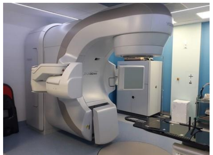
Acelerador lineal de última generación instalado en el Hospital Clínic de Barcelona
